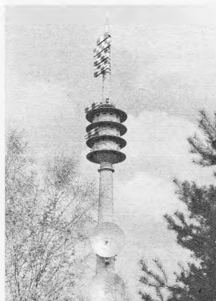
Bild 3. Der Fernmeldeturm auf dem Schäferberg in West-Berlin im heutigen Ausbaustand. Er wurde bereits am 17. Juli 1964 seiner Bestimmung übergeben (Aufnahmen: Dennewitz)
